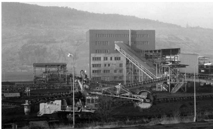
Depo uhlí v Trmicích, v pozadí uhelné prádlo, v popředí kolesový redeponovací stroj (foto K. Walter)
