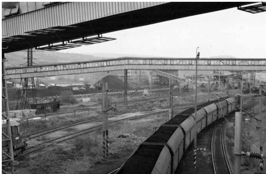
Obdobytové místo v Trmčich. V pozadí vlevo depo uhlí, v pozadí vpravo objekt hrubé drtírny, vodorovně středem fotografie vede zakrytý most, ve kterém je umístěn lanopásový dopravník. Nahoře most vedoucí do jemné drtírny a dole naložené vagony ČSD energetickým uhlím. (foto K. Walter)
