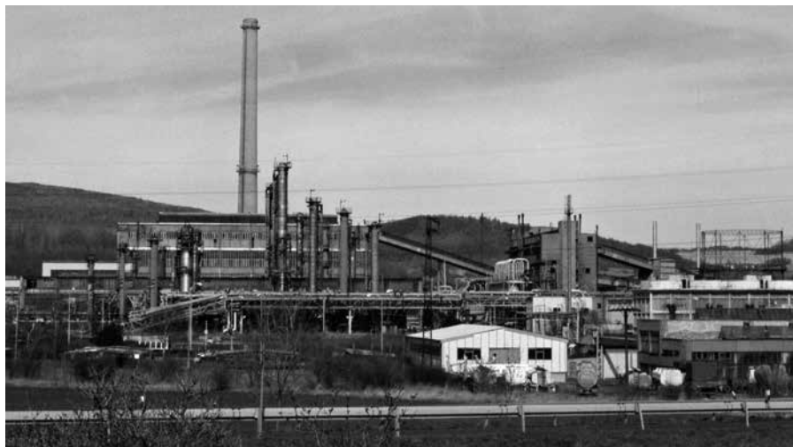
Tlaková plynárna Úžín, pohled od jihu (foto K. Walter)
