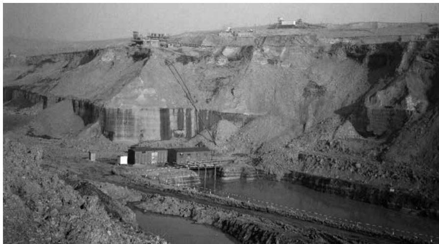
Hlavní čerpací stanice v lomu. Nahoře jsou poháněcí stanice pásových dopravníků, vlevo je uhelná sloj. V boku vodní jímky je vidět střídání vrstev uhlí a jílovců v podloží sloje. (foto K. Walter)
