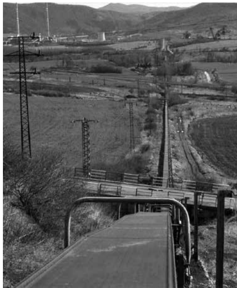
Pohled na lanopásový dopravník ze Střížovického vrchu směrem jižním. V pozadí vlevo teplárna Trmice a vpravo kolesové rýpadlo, těžící první řez lomu (foto K. Walter)
